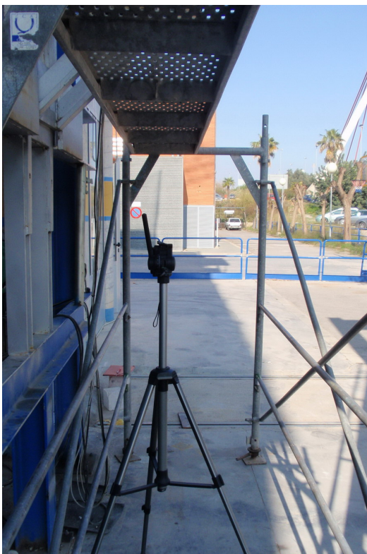
Fotografía 12: Imagen del proceso de medición de la deformación máxima de la plataforma de trabajo bajo carga, mediante medidor láser calibrado (54427-2-1)
