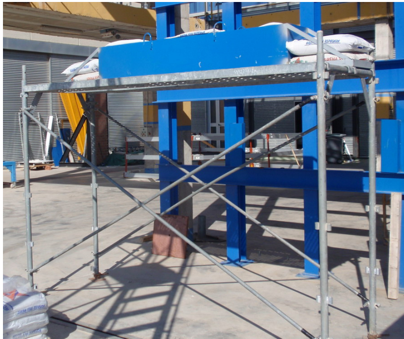
Fotografía 6: Vista de detalle de la muestra evaluada, durante proceso de ensayo, con 1 módulo de 1 altura, con la carga uniformemente distribuida.
