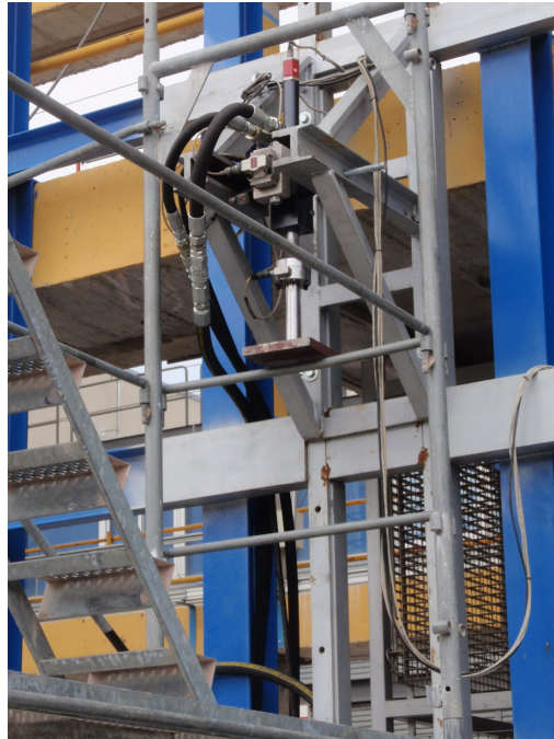
Fotografía 17: Detalle de la aplicación de la carga estática vertical descendente.
