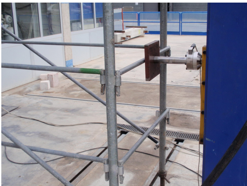
Fotografía 20: Detalle 1 aplicación carga estática horizontal sobre barandilla principal de la protección lateral del andamio estructural de fachada objeto de ensayo (54427-3-3)
