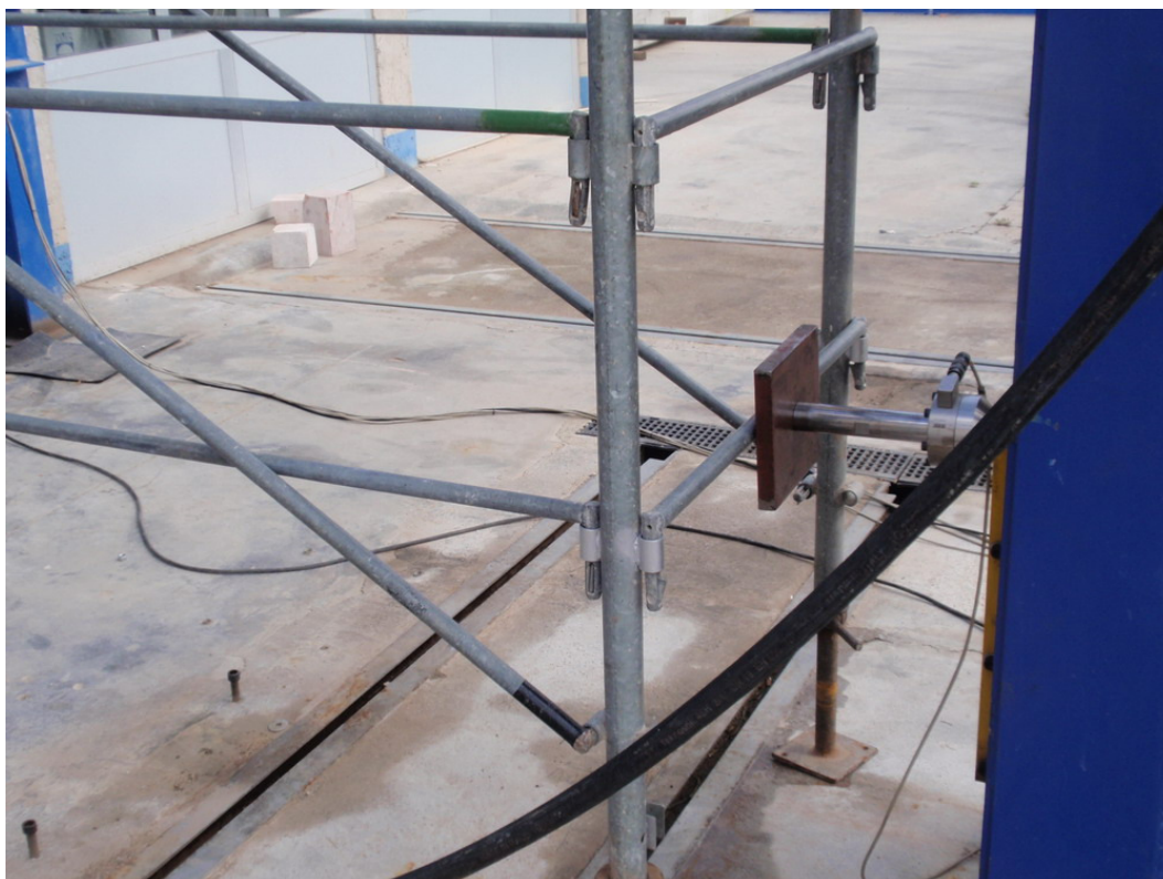
Fotografía 22: Instantánea aplicación carga estática horizontal sobre barandilla intermedia de la protección lateral del andamio estructural de fachada objeto de ensayo (54427-3-3b)
