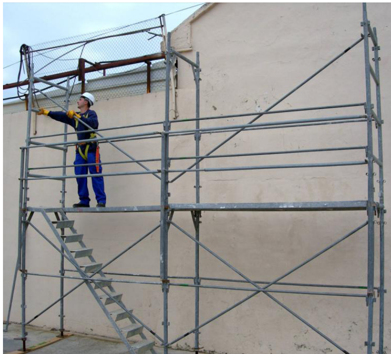
Fotografía 2: Vista general del proceso de montaje in situ del sistema, con 2 módulos de 2 alturas.
