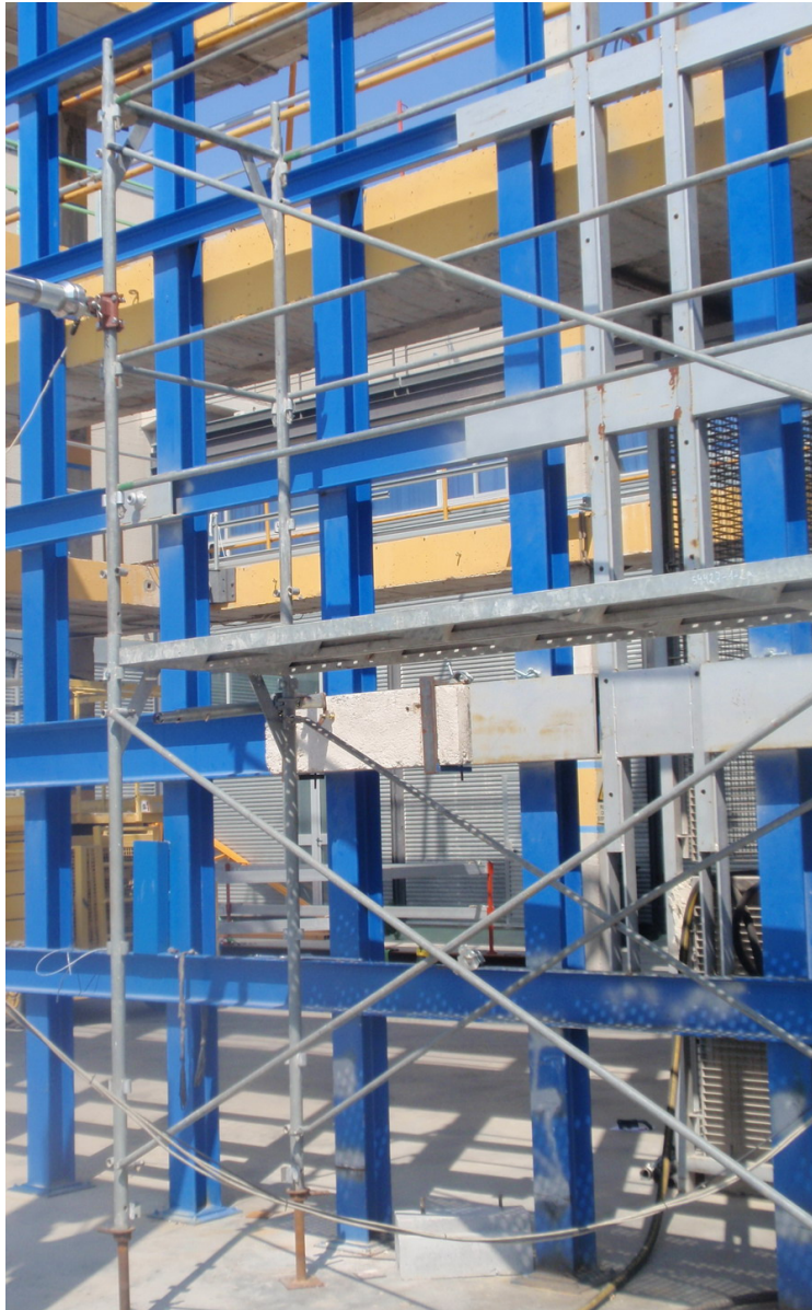
Fotografía 5: Vista general de muestra a evaluar, durante proceso de ensayo, con 1 módulo de 2 alturas, en el que se pueden identificar los marcos verticales, las riostras diagonales y horizontales, los husillos y las plataformas de trabajo.
