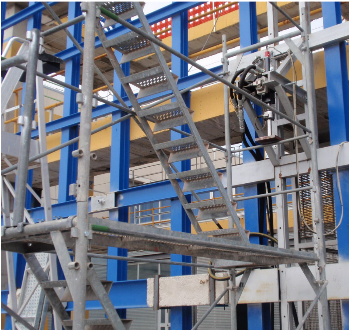
Fotografía 16: Instantánea del proceso de aplicación de la carga estática vertical descendente sobre la zona central (zona más desfavorable) de la barandilla principal de la protección lateral del módulo del andamio estructural de fachada objeto del ensayo (54427-3-1)
