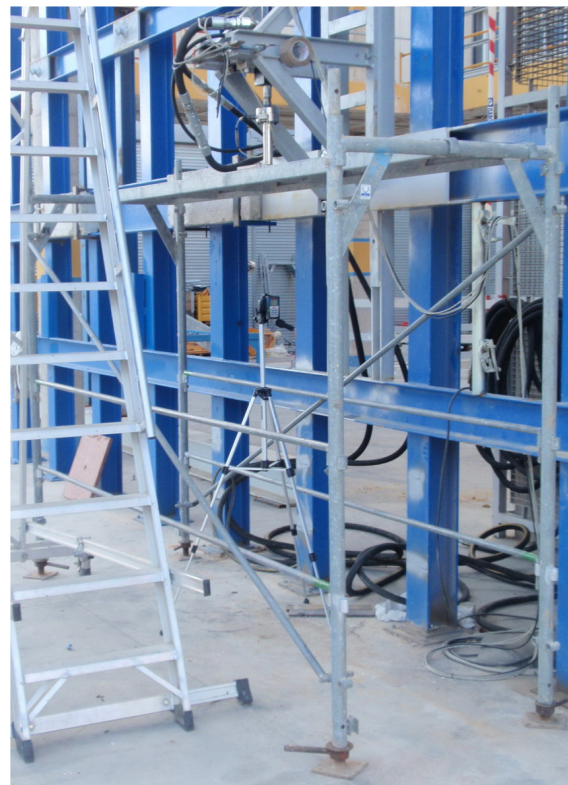
Fotografía 13: Vista general del momento de aplicación de la carga concentrada (54427-2-1)
