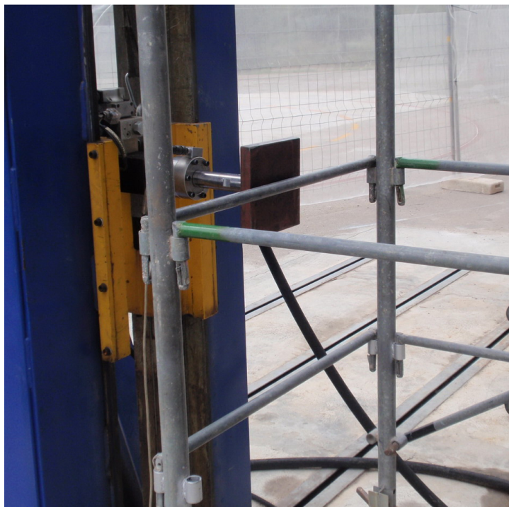
Fotografía 21: Detalle 2 aplicación carga estática horizontal sobre barandilla principal (54427-3-3a)
