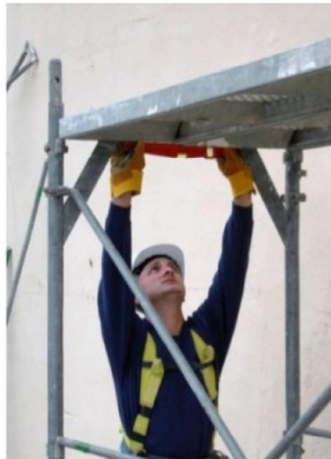
Comprobaremos la distancia de separación del andamio a fachada, considerando que conforme establecen las normas UNE al respecto, y así se deberá establecer en el Plan de Montaje Particular, esta distancia podrá suponer la instalación en su caso, de barandillas completas por el lado de la fachada.
