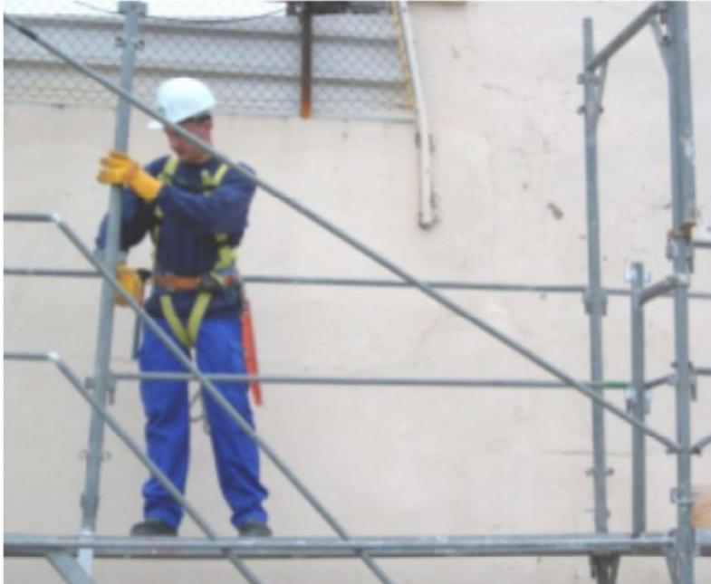
Por último, fijar el agarre montante superior al montante 2000 y al travesaño superior del módulo de cierre.
